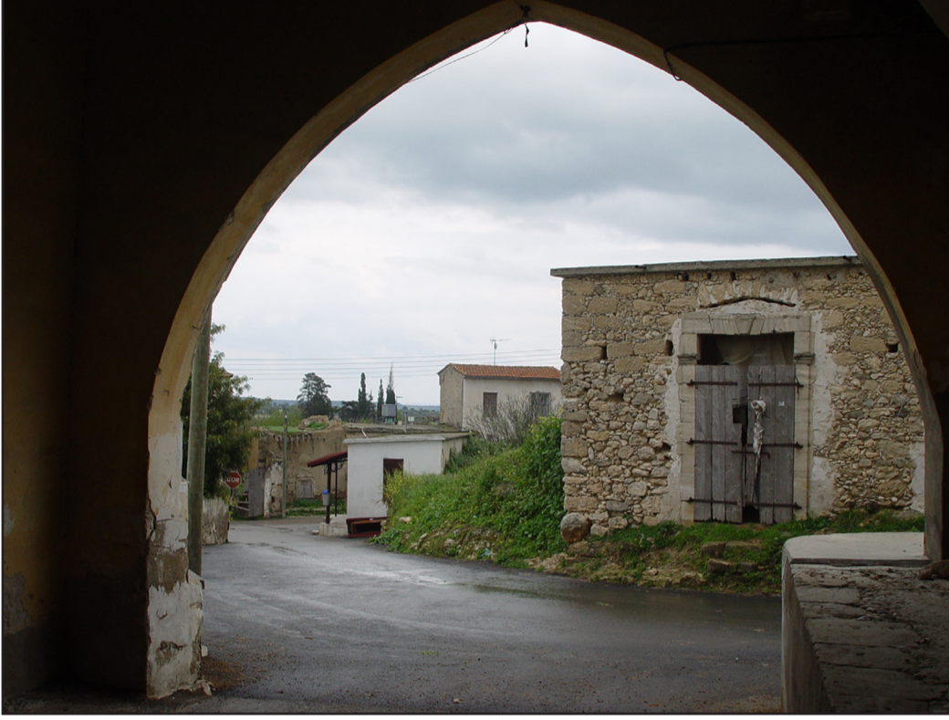
Taş malzeme ile inşa edilmiş geleneksel bir yapı (fotoğraf: Şebnem Hoşkara)
