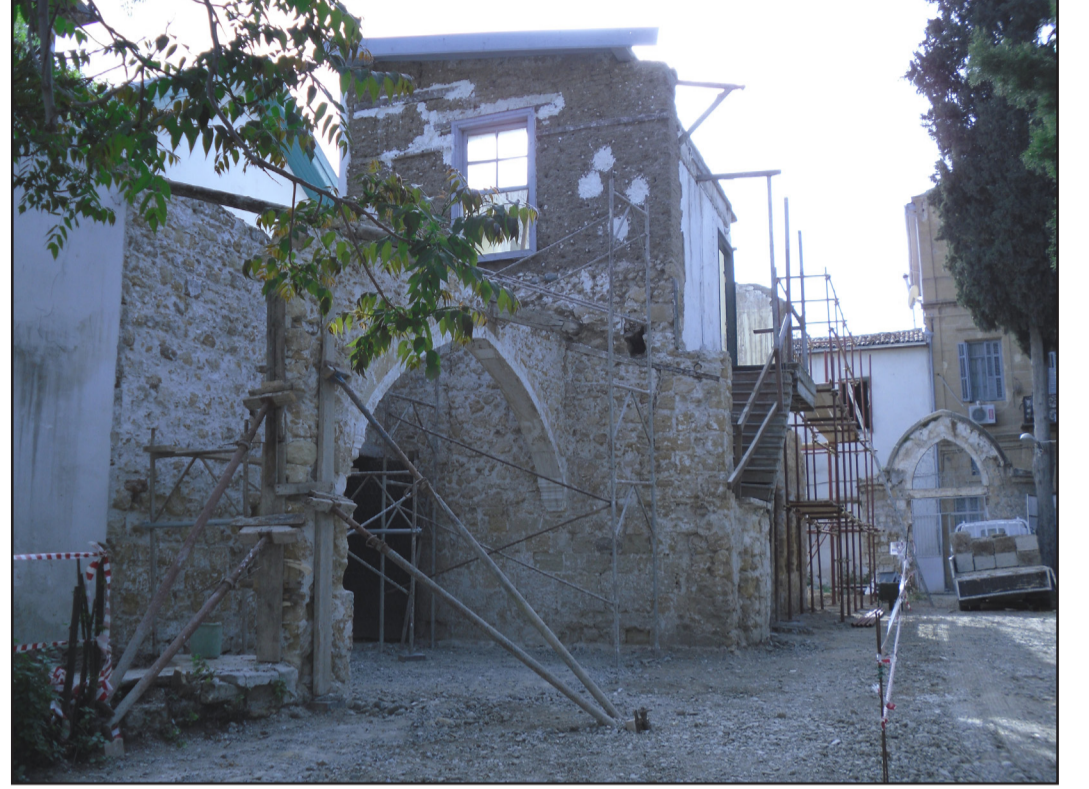
Zemin kat taş, birinci kat kerpiç malzeme ile inşa edilmiş geleneksel bir yapı (Lefkoşa Ermeni Manastırından bir bina)
